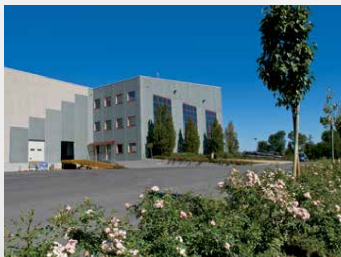
Le nouveau Magasin d'Allied International à Castel San Giovanni (Piacenza), Italie: les bureaux
